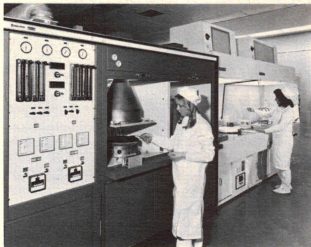
Afb. 3. In deze oven wordt de (laatste) metallisatielaag opgebracht voor aansluiting van de chip met de pennen.
